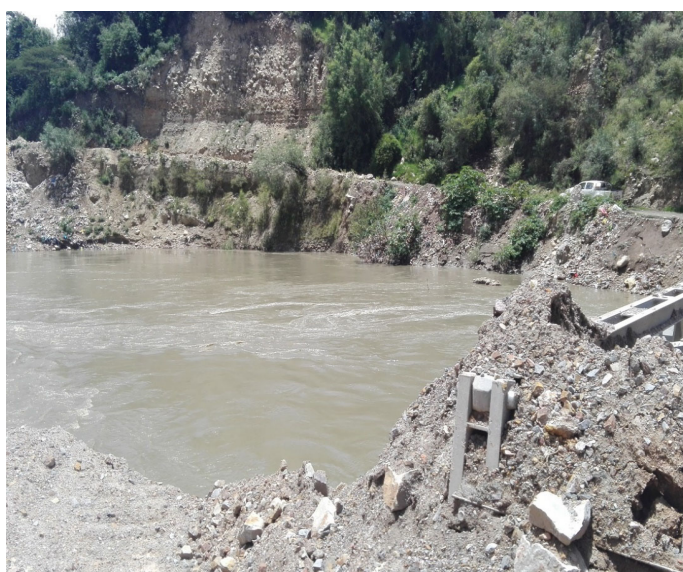
Imagen 2: Vista del Río Santa donde se observa el daño ocasionado a la estructura de protección debido al incremento del flujo
